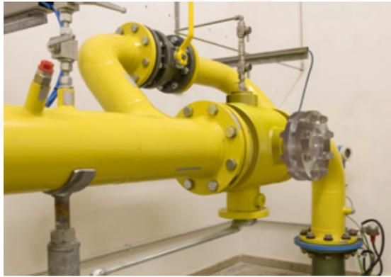
Statt der klassischen Einbauweise in der Rohrleitung wird bei der OWE die Impfdüse direkt im Kugelhahn installiert.
